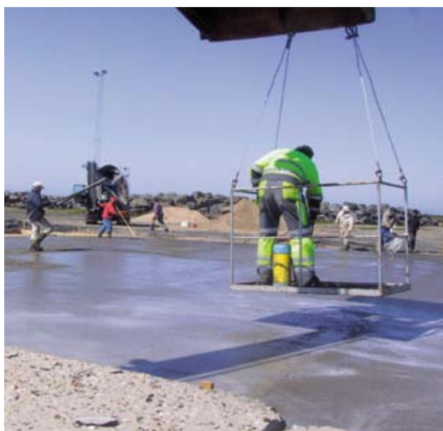
Figur 10. Påføring af forseglingsmiddel på store felter.
