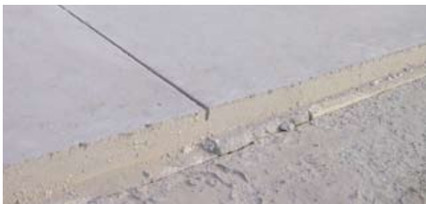
Figur 2. SCC gulv med perfekte kanter og skårne fuger.
