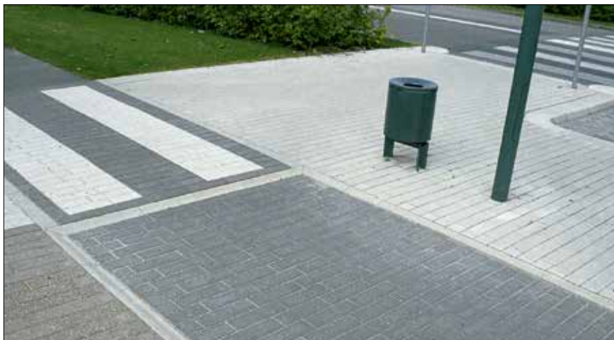
Adskillelse af biler, cykler og fodgængere kan ske smukt og effektivt med betonsten i forskellige farver og varierende overflader. Etableret i 1997 (Allerød).
