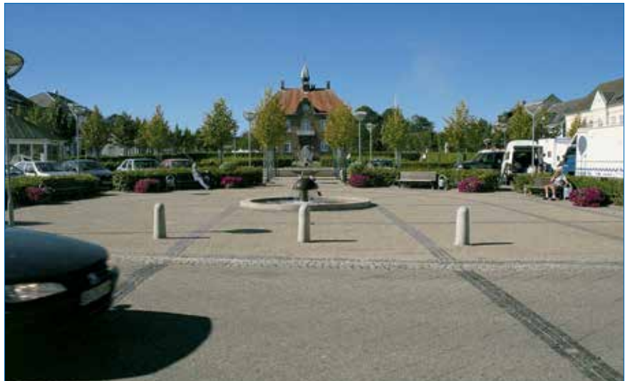
Farten dæmpes uvilkårligt når man kører fra en asfaltvej ind på betonsten. Her er vejen en smuk og integreret del af et torv. Etableret i 1993 (Kjellerup).
