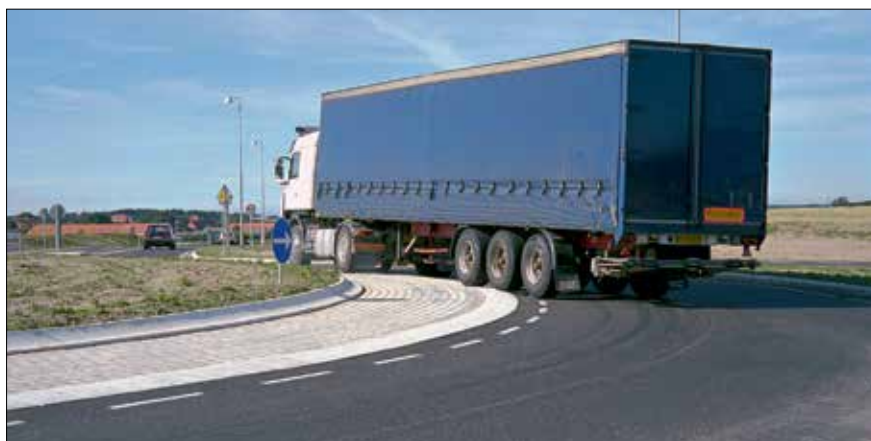
Rundkørsler er effektive både som fartdæmpere og til afvikling af trafikken. Her er anvendt lyse betonsten og specielle rundkørselskantsten til det overkørselsareal, der benyttes af større lastbiler og busser.
