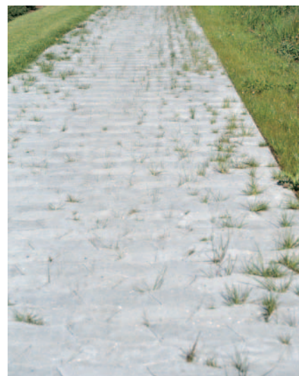
Nye fuger er ofte ikke fyldte og komprimerede, hvilket giver ukrudtet frit spil.
