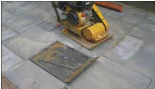
Figur 3.42. Kunststofsålen kan fremstilles af PEHD-plade.
