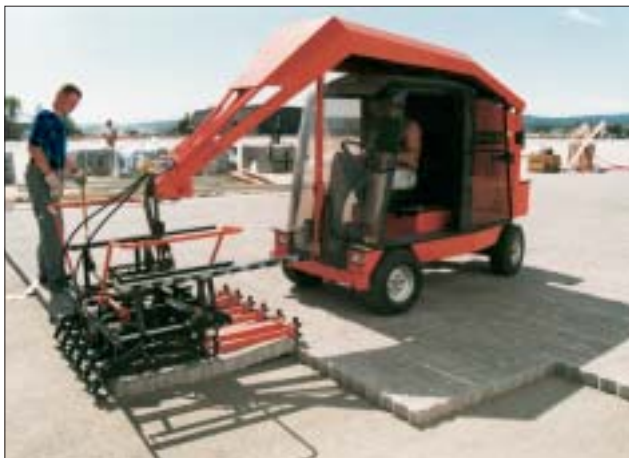
Maskinnedlægning af belægningssten - hurtigt og effektivt.
