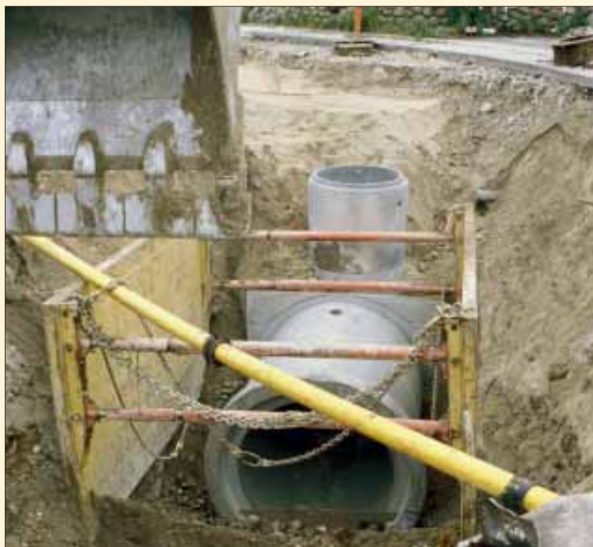
Lægning af Ø1600 mm betonrør. Gravekassen begrænser rørgravens bredde.
