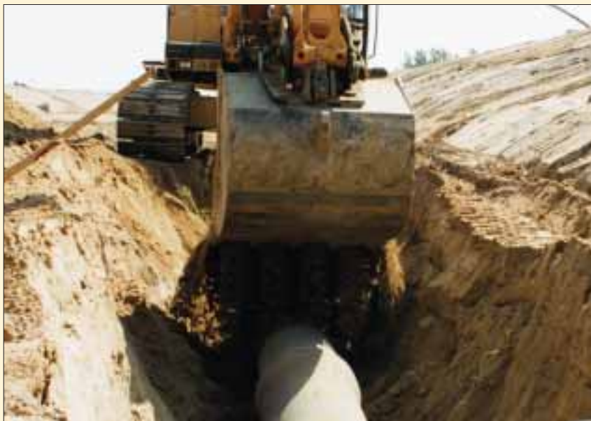
Der kan arbejdes tæt på de robuste betonafløbskomponenter. Dette letter det manuelle arbejde med tilpasning af grusmaterialer i rørgraven.
